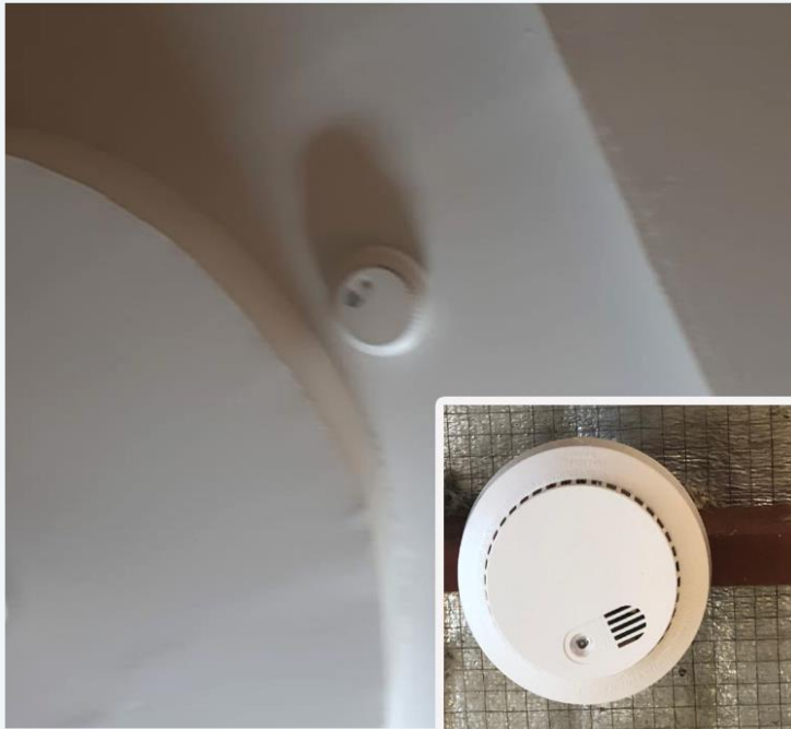
تركيب كاشف دخان بفرقة المريض
